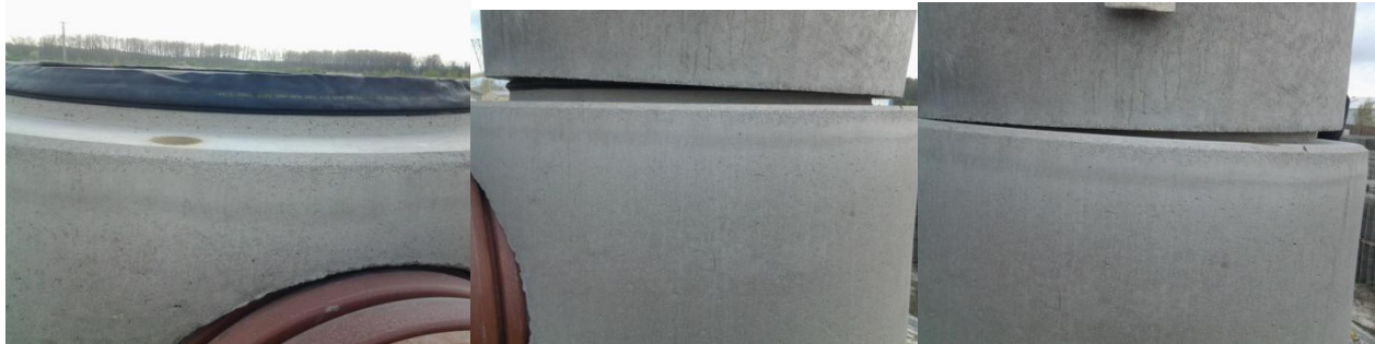
Az elemek összeillesztése nem koncentrikus, ezért korrigálás szükséges
