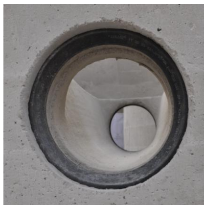
Csőcsatlakozások tömítése gyárilag, az aknafenek elem hornyába ragasztva
