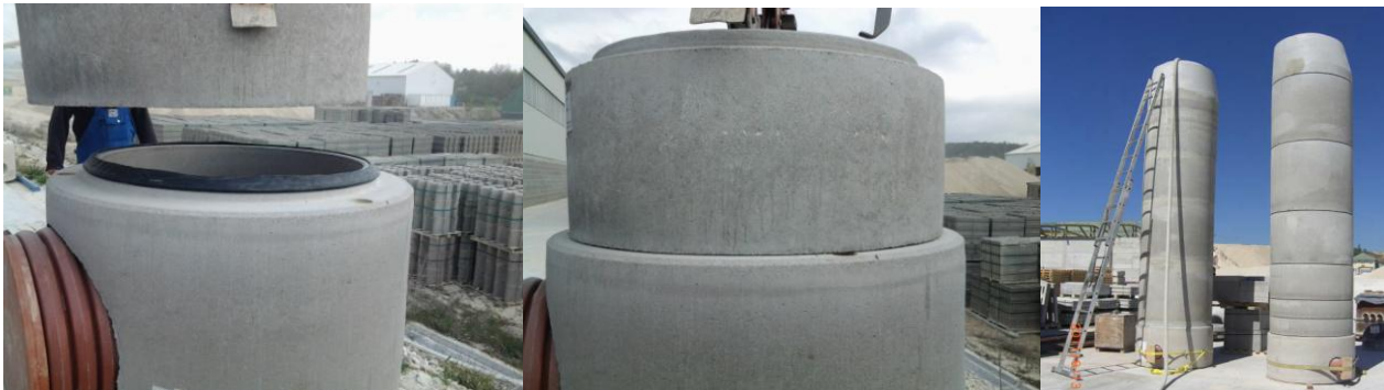
Az alsóra rákerülő elem újbóli megfogása és illesztése már helyes (baloldali és középső kép), a jobboldali képen 2 db 5 m magas akna üzemi vízzárósági ellenőrzése látható (a baloldali habarcsos illesztéssel, a jobboldali gumitömítéssel készült)
