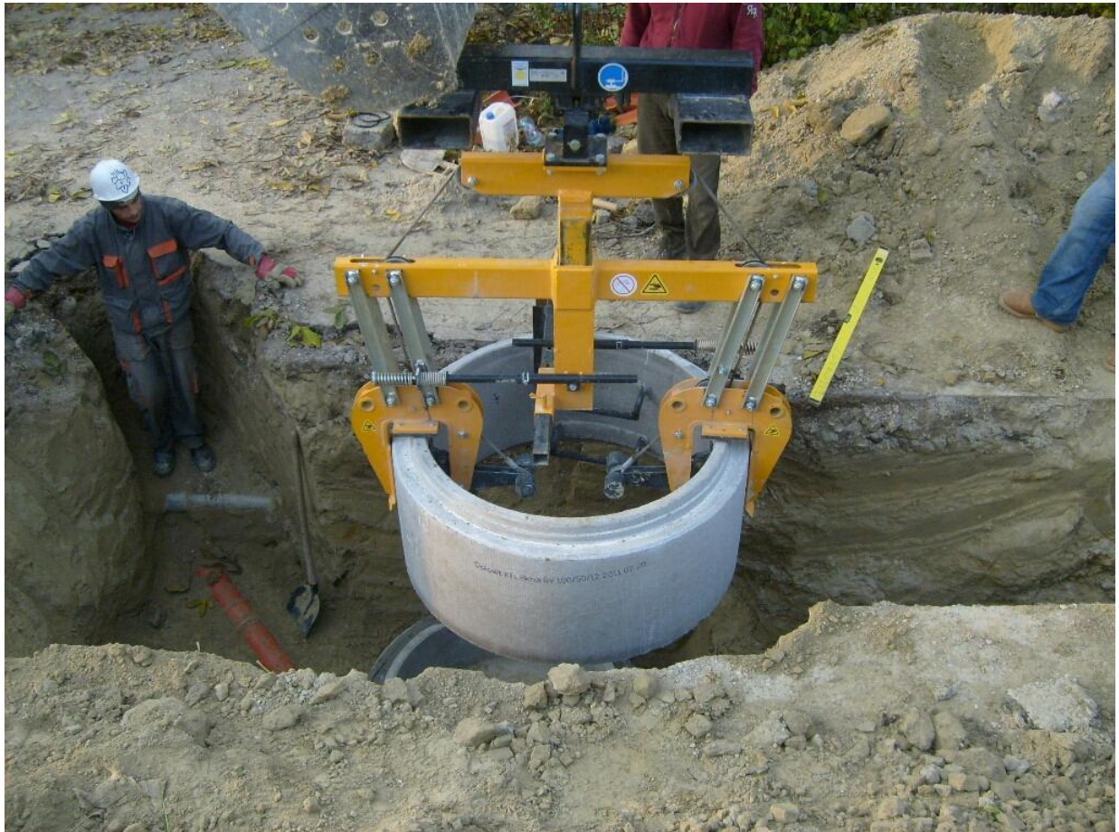
Beépítés kétágú emelő adapterrel
