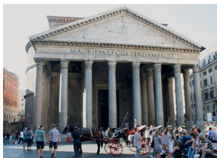
Az Augustus császár idején emelt híres Pantheon építéséhez is felhasználták alapanyagként a pozzolana nevű vulkáni hamut. Forrás: Wikimedia Commons/Jean-Pol Grandmont
